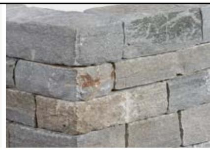
! Bei der Verlegung der Mauer wurden die Mauersteine nachträglich präzise nachbearbeitet, um eine gute Passgenauigkeit zu gewährleisten. Die Verlegung durch einen GaLaBau-Fachbetrieb wird empfohlen!
